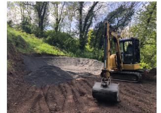
CRÉATION D'UNE PISTE DE PUMP TRACK
