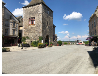
TRAVAUX DE VOIRIE
