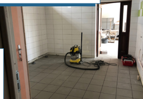
TRAVAUX WC ÉCOLE
